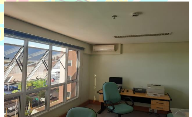
Figura 6 – Evaporadora instalada na sala do RC para ser retirada – Evaporadora nova deverá ser instalada em outro local conforme figura 12
