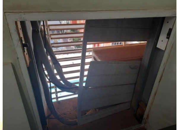
Figura 8 – Área Técnica – Sala do Atendimento
