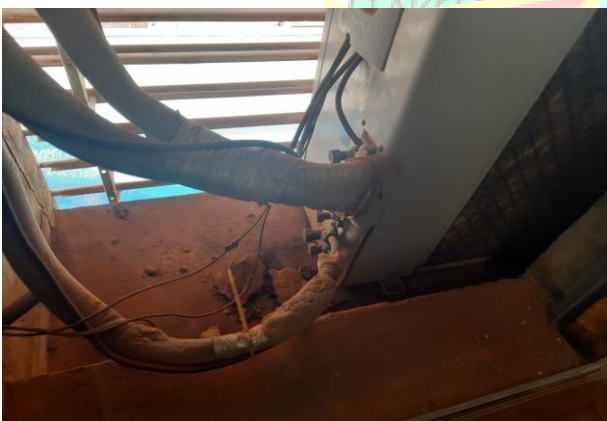
Figura 3 - Dutos isolados em conjuntos – Serão retirados e instalados os novos com isolamentos individuais.
