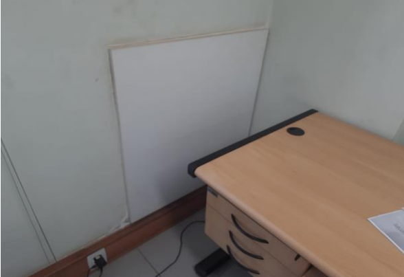
Figura 7 – Porta de entrada da área técnica (local onde estão instaladas as condensadoras) – Sala do Atendimento
