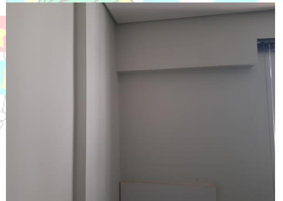
Figura 12 – Local acima da porta para a condensadora, para ser instalada a evaporadora.
