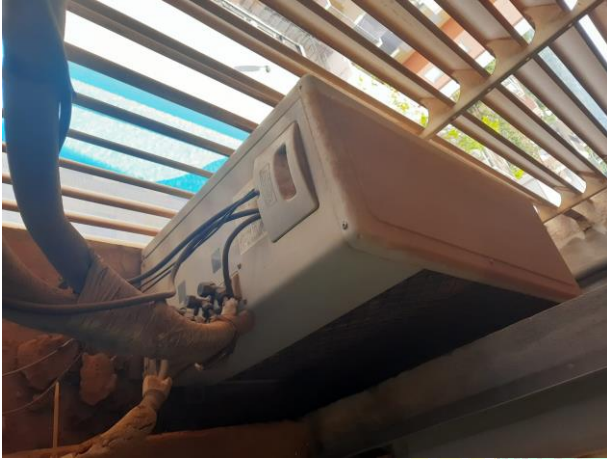
Figura 1 – Condensadora de tri-split para ser retirada
