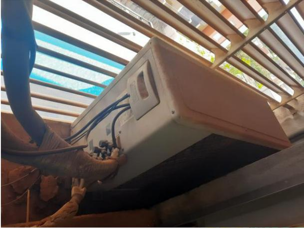
Figura 1 – Condensadora de tri-split para ser retirada
