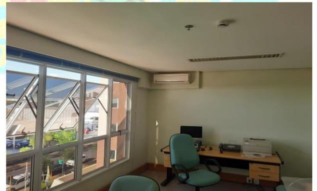
Figura 6 – Evaporadora instalada na sala do RC para ser retirada – Evaporadora nova devera ser instalada em outro local conforme figura 12
