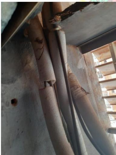
Figura 9 – Dutos instalados e isolados em conjunto – Sala do Atendimento
