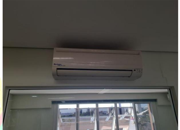
Figura 2 – Evaporadora mais distante da condensadora, em torno de 10 metros. -
