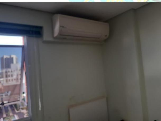
Figura 5 - Evaporadora para ser retirada e substituída pela nova – Sala de Atendimento
